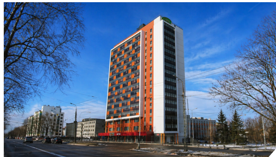
Жилой дом по пр. Первомайскому
