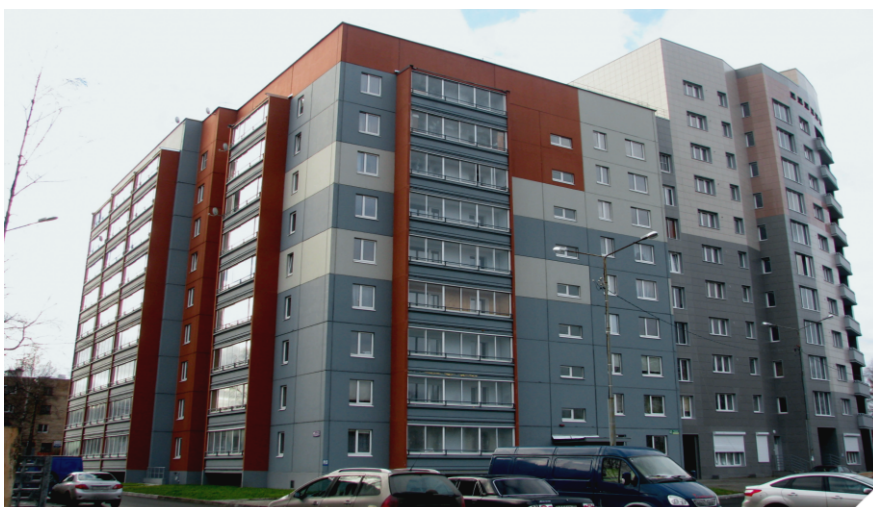
Жилой дом по ул. Зайцева
