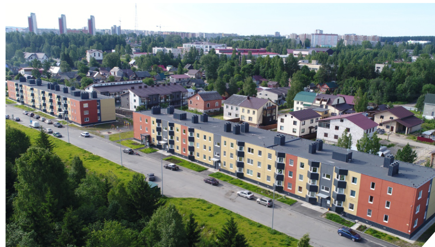
Жилые дома по ул. Муезерской
