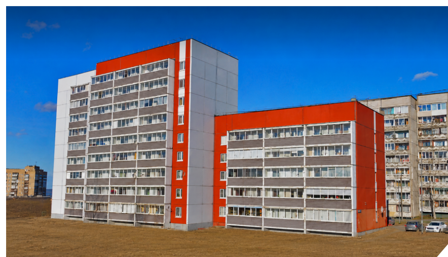
Жилой дом по ул. Гвардейской
