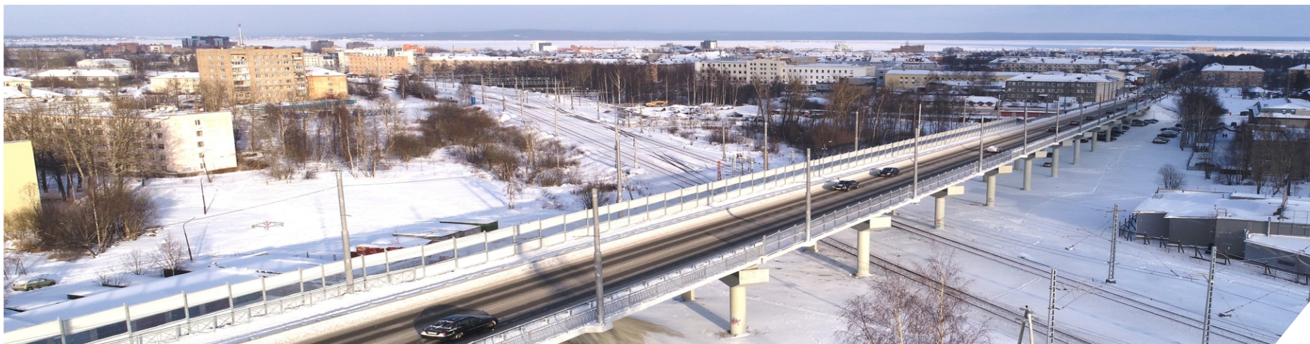
Гоголевский путепровод в г. Петрозаводске
