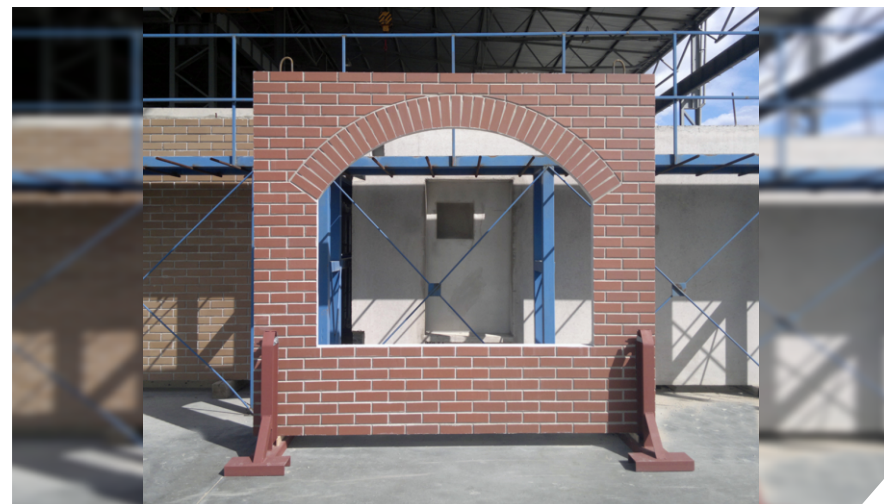
Наружная панель с отделкой клинкерной плиткой
