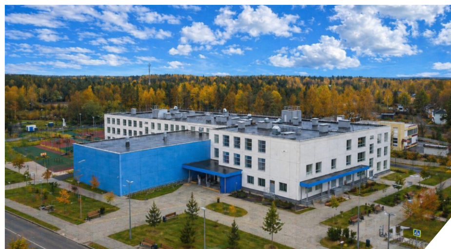
Школа на 330 мест в г. Суоярви
