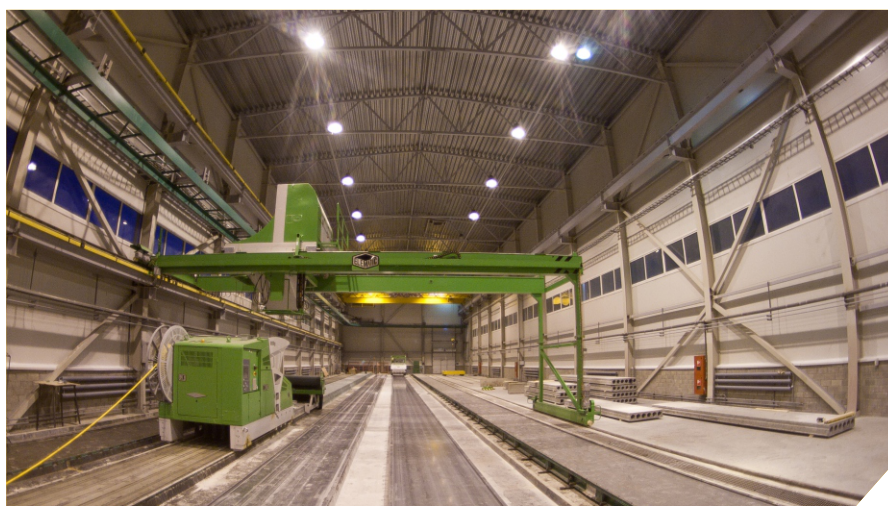
Цех пустотных плит
