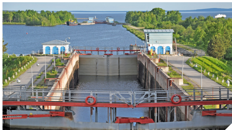
Реконструкция шлюза №2 Беломоро-Балтийского канала
