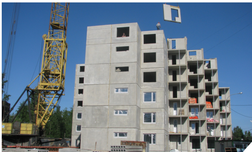
Высокая скорость монтажа
