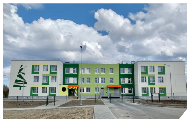
Детский сад на 300 мест по ул. Хейкконена
