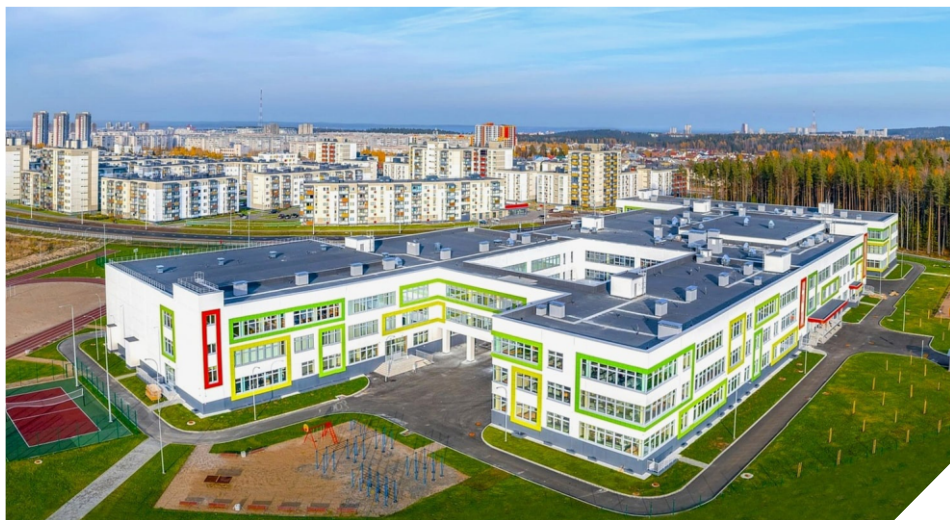
Школа на 1350 мест в г. Петрозаводске
